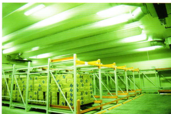
図5 布製冷風ダクト採用保冷库 1)
