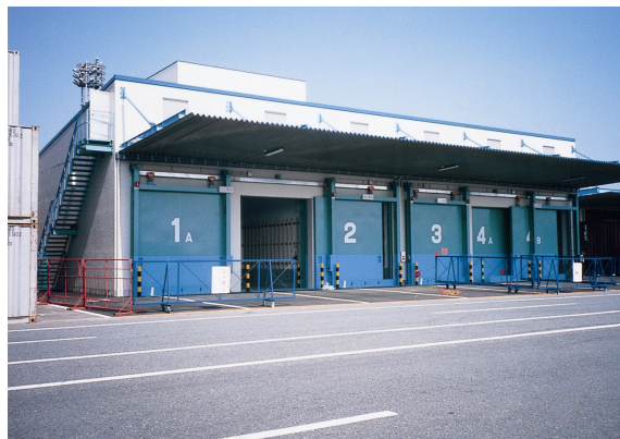
図11 くん蒸施設全体外観 1)
