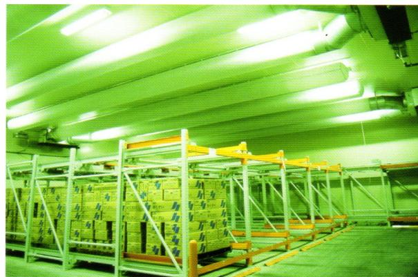
図5 布製冷風ダクト採用保冷库<sup>1)</sup>
