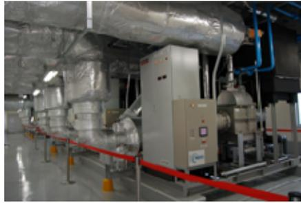
図8 空気冷凍システム「パスカルエア」
