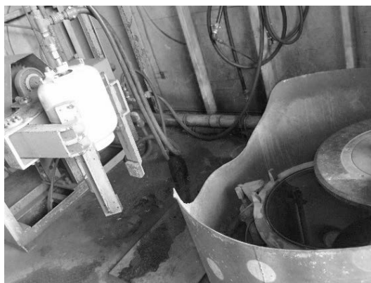
図10 冷媒ボンベ検査
